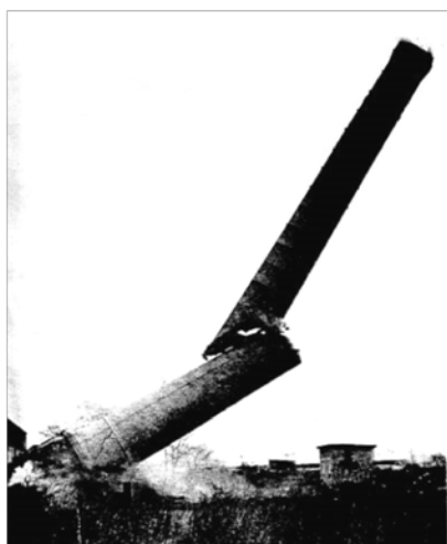
Obr.1a, b, c Padajúci komín. Tyčový model komína. Padajúca veža kociek, pevne spojených k základni.
